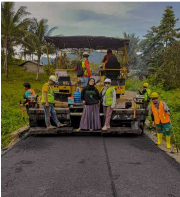
Gambar 3.8 Pembangunan Infrastruktur Jalan
